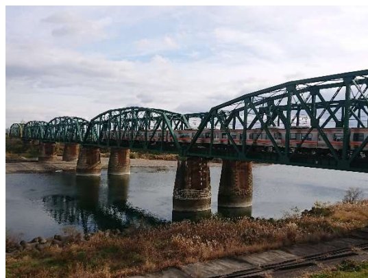
a)濃尾地震による被害状況 (1891 年) 1-2) b)現在の様子 (ウエル基礎, 2020 年撮影)
