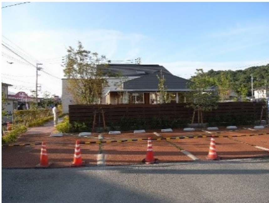
Photo1-3 木質ラームを用いた建築物（事務所）
