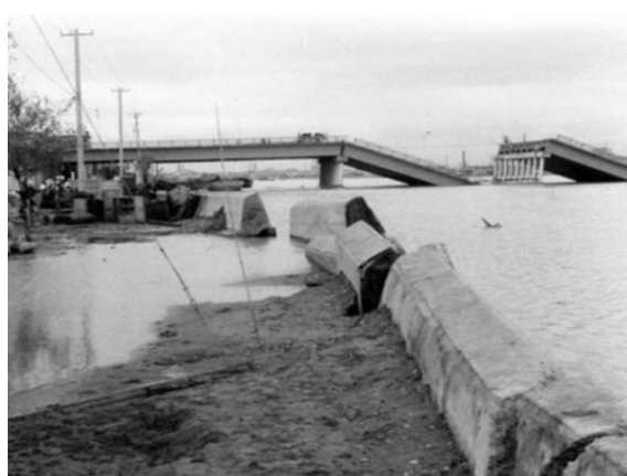
(d) 側方流動による護岸の被害 18)
