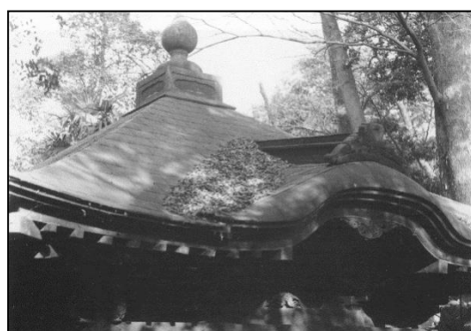
④昭和前期(昭和10年)：銅板葺 a、露盤 iii
