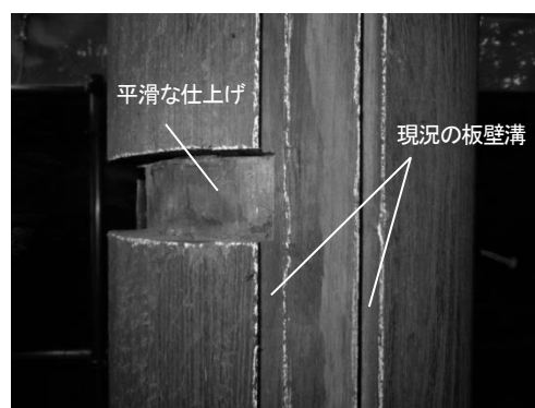
④北東隅柱に残る棚板の痕跡(西より)
