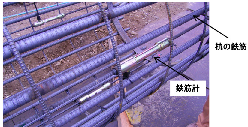
図-4.5.4(a) 鉄筋計（埋設前）
