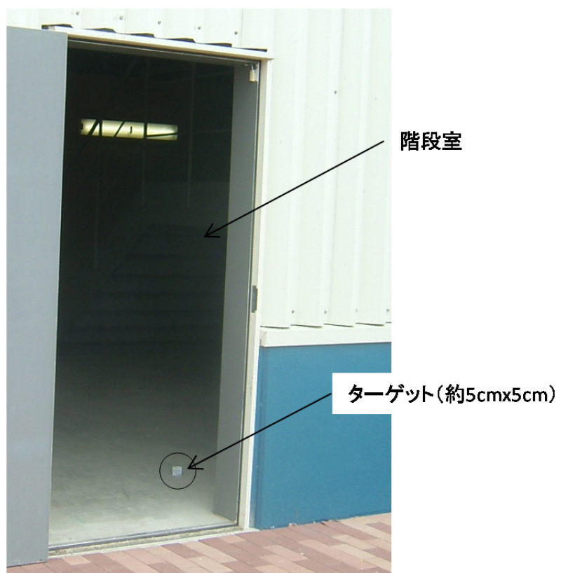
図-5.5.6 レベル計測のターゲット設置状況
