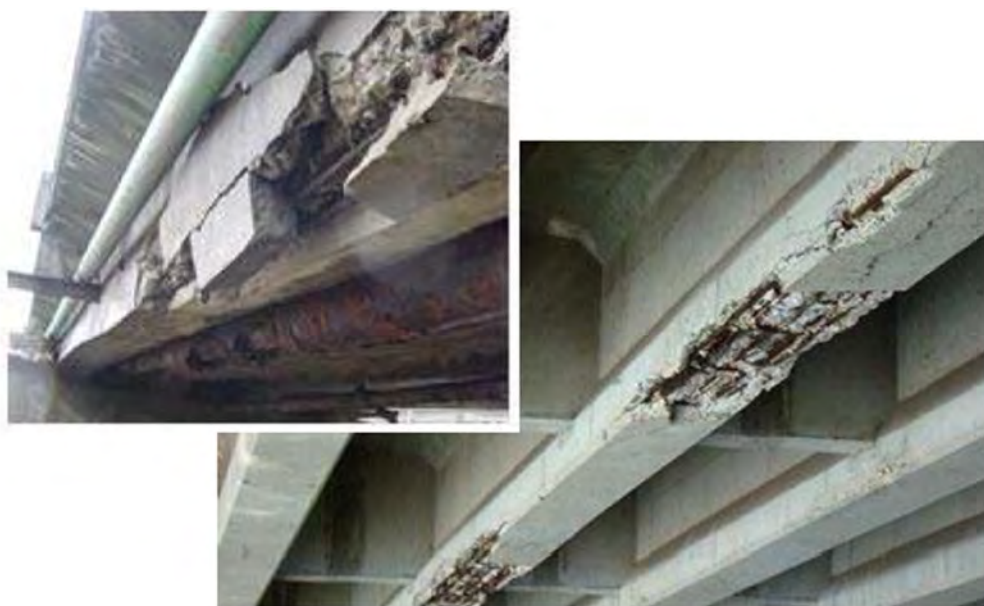
図 1-2 鉄筋腐食と腐食ひび割れによる劣化 2)
