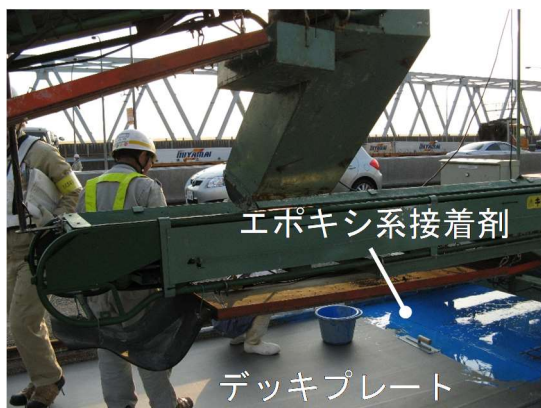
(c) エポキシ系接着剤の塗布状況
