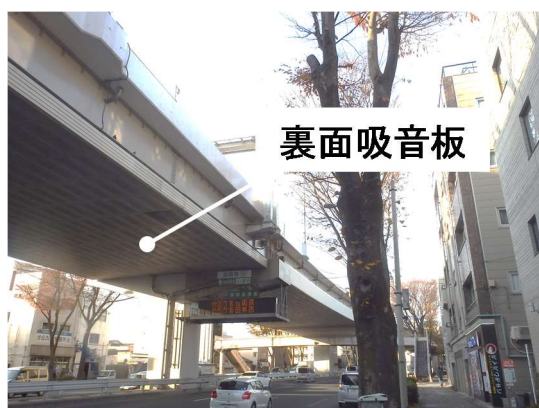
(a) 裏面吸音板の設置された橋梁
