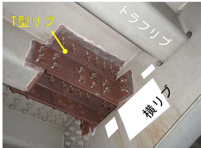
(b) 補強例 (写真提供：首都高速道路(株))
