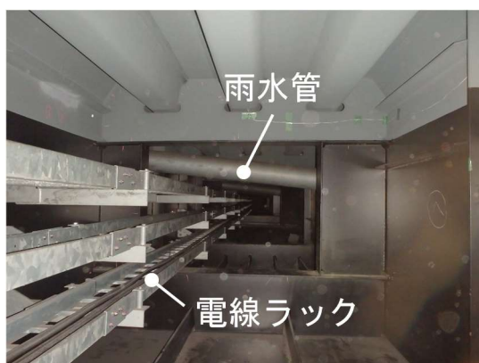
(a) 箱桁橋梁の主桁内部
