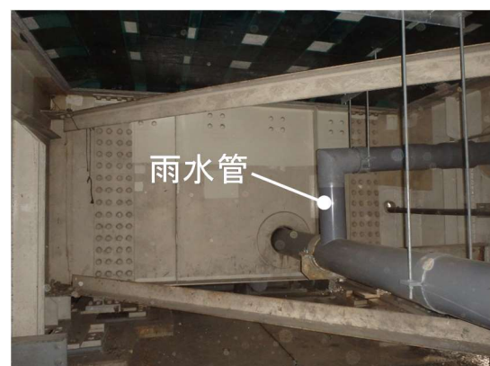
(b) 裏面吸音板上の橋梁内部
