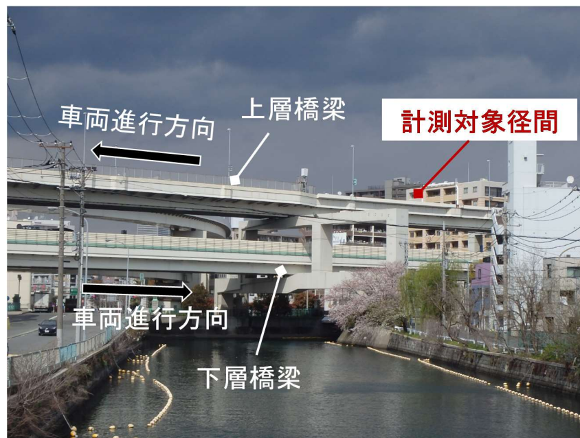
写真 3-1 対象橋梁の外観（著者撮影）
