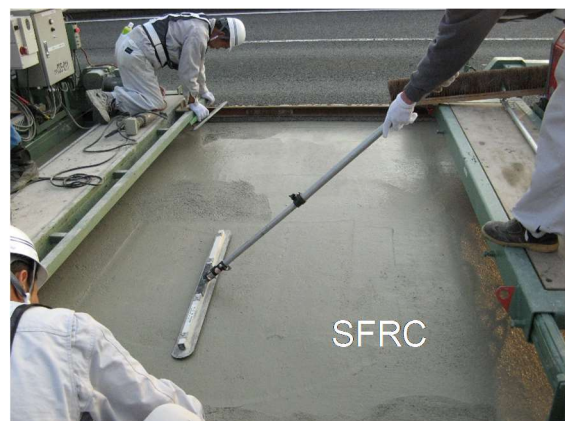
(d) SFRC の打設状況
