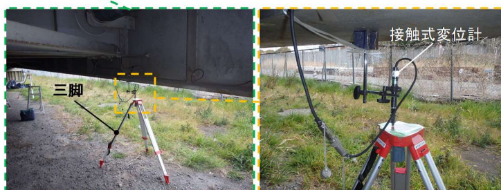
図 1-4 接触式変位計による主桁たわみの計測事例（著者撮影）
