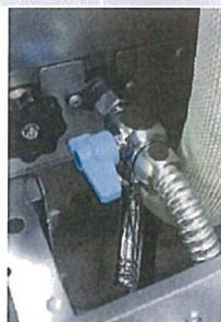
戸建用貯湯ユニット排水配管 (集合用EFでも対応予定、ただし別部材)
