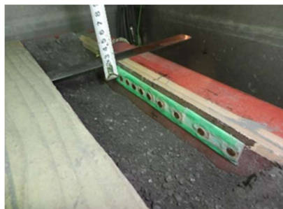
写真-2.6 圧力計の設置
