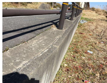
写真-1.4 プレキャストL型擁壁の転倒，沈下(県道 千葉県)
