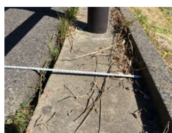
b. L型擁壁の沈下
