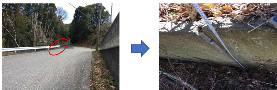
b. 千葉県，県道，左の写真は道路現況，右の写真は擁壁前面
