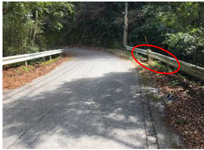
a. 道路現況
