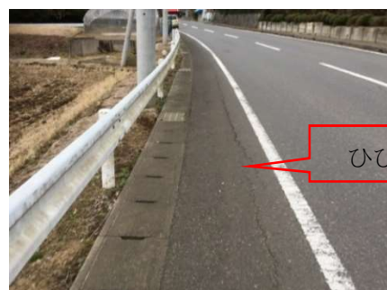
b. 擁壁舗装面
