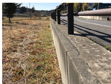
写真-1.4 プレキャストL型擁壁の転倒，沈下(県道 千葉県)
