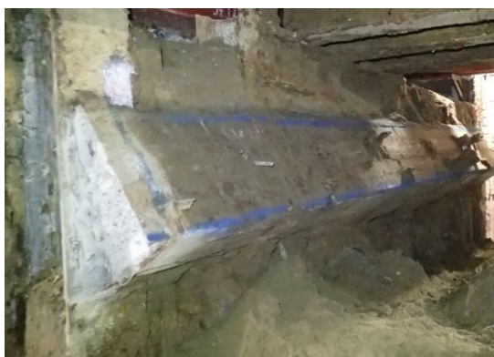
アースアンカー受台コンクリート
