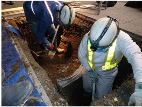
STEP3-1 掘削作業
