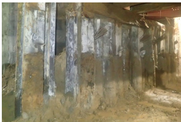
既設構造物山留壁（SMW）
