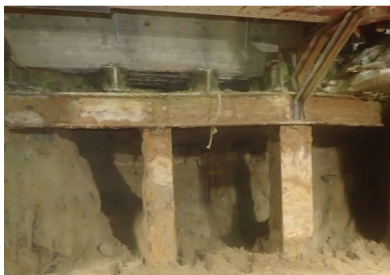
既設地下構造物受台鋼材
