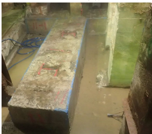
残置鋼材受根巻コンクリート
