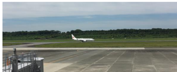
図 6-5 熊本空港の滑走路の様子
