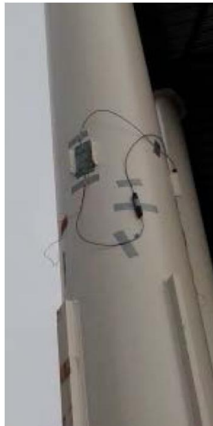
図 2-17 ひずみセンサーが取り付けられた Scott Hall の柱 27)
