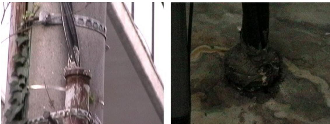
(a) 屋外電柱立ち上り部の電線管端部 (b) 借室内ケーブル引込み部分(流水痕あり)
