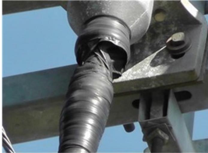
図 1.17 ビニルシースのシュリンクバックによりテープ処理部からの浸水が疑われる例
